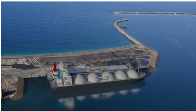
Source: Port Kembla LNG import terminal, Squadron Energy
